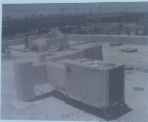
Sl. 2.48 Mono blok model klima uređaja proizvodnje LG, montiran na ravni krov trgovačkog centra, srednje veličine kapaciteta od 16 kW
