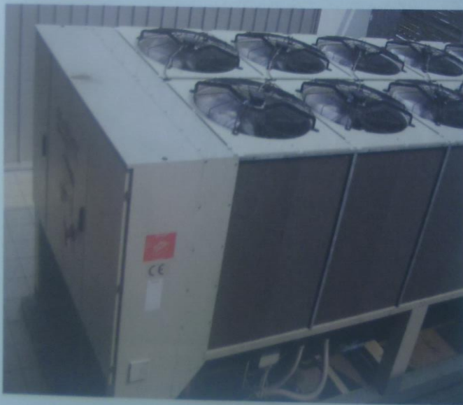
Sl. 2.51 Rashladna mašina (Air Condition) za hlađenje trgovačkog centra "Merkator"
