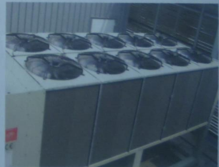
Sl. 2.51 Rashladna mašina (Air Condition) za hlađenje trgovačkog centra "Merkator"
